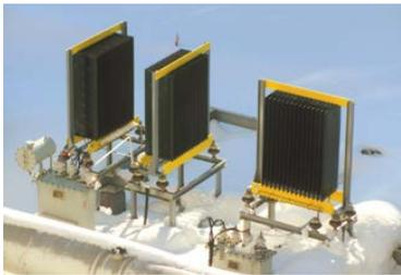
Рис. 4. Резисторы на основе композиционного материала в сети СН Камчатской ТЭЦ-2
