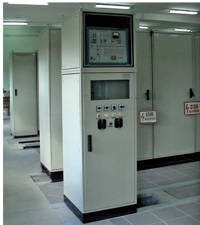
Рис. 11 Первый шкаф микропроцессорной ДФЗ производства ва НПП «ЭКРА» с ВЧ-постом типа ПВЗ-90М1
