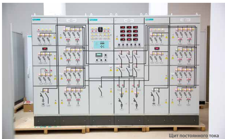
Щит постоянного тока
