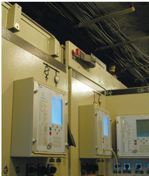
Фото 2. Терминалы ЭКРА 211 в ячейках КРУ Верхне-Мутновской ГеоТЭС
