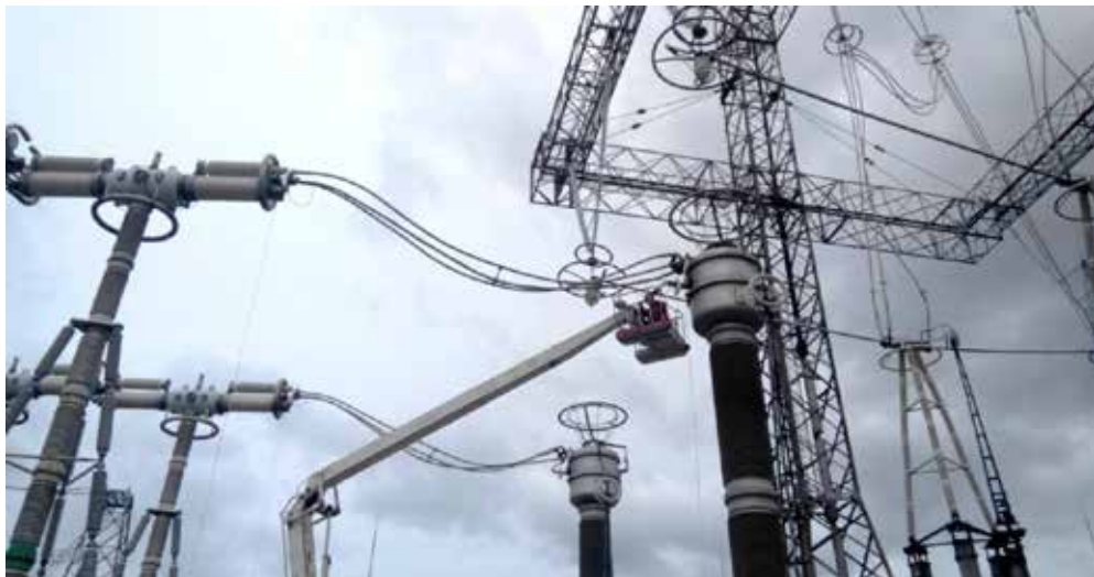
Рис. 10. Монтаж системы защиты на ОРУ-750 кВ Смоленской АЭС
