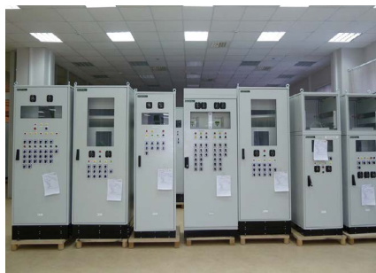
Рис. 3. Варианты исполнений внешнего вида шкафов ШМЭ
