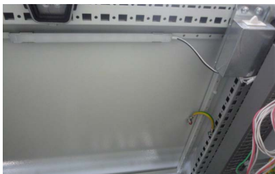
Рис. 12. Установка LED-светильника в шкафу
