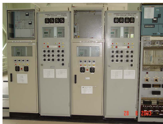
Рис. 1. Первые шкафы серии ШЭ2607 на ПС Киндери-500
