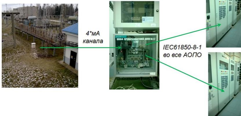
Рис. 8. Передача данных о температуре окружающей среды при применении ШНЭ 9933.001 (фото Заинская ГРЭС)
