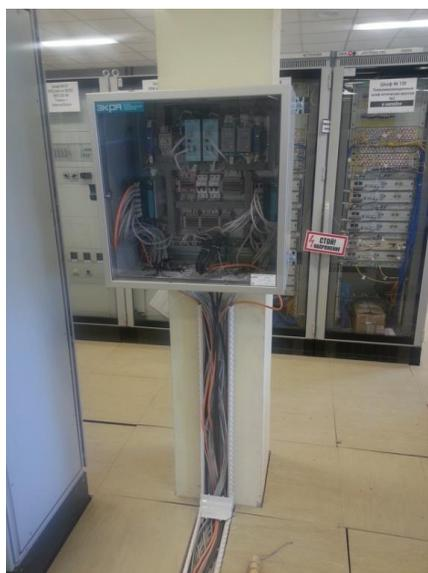
Рис. 7. Шкаф с промежуточными преобразователями для АОПО(t) навесного исполнения типа ШНЭ 9933.001 (фото ПС 500кВ Тамань – Крымский энергомот)
