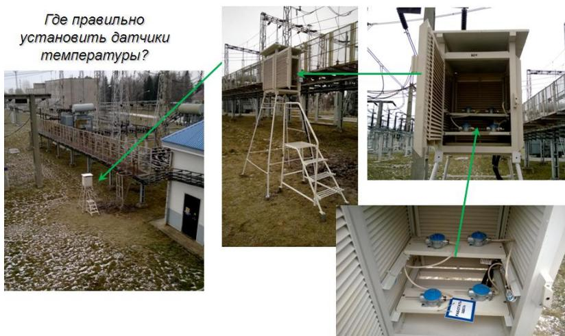
Рис. 6.1. Организация метеобудки с измерением температуры воздуха на Заинской ГРЭС
