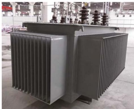
Группа «Трансформер» приступила к производству силовых трансформаторов с сердечником из аморфных сплавов.
