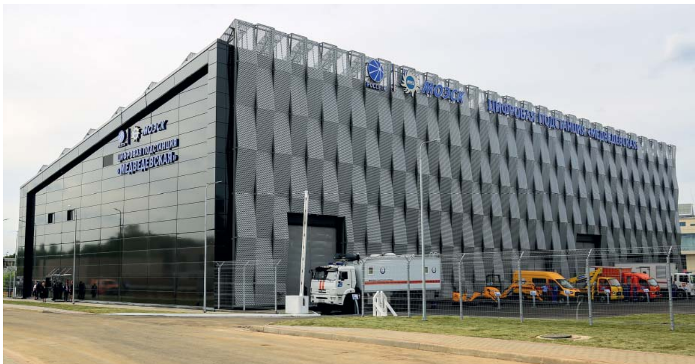
ПС 110 кВ «Медведевская» — первая в московском регионе цифровая подстанция
